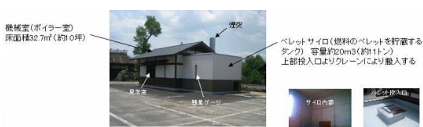
ペレットボイラー機械室及びサイロ
